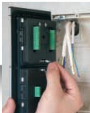
Conectar los módulos entre si mediante los latiguillos
