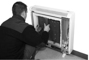
10.- Sitúe de nuevo las resistencias en su posición inicial, de forma vertical. Coloque el piso inferior de ladrillos con la cara lisa hacia el exterior y sobre las lengüetas de las resistencias. Acabe de montar los ladrillos, colocando el piso superior.
